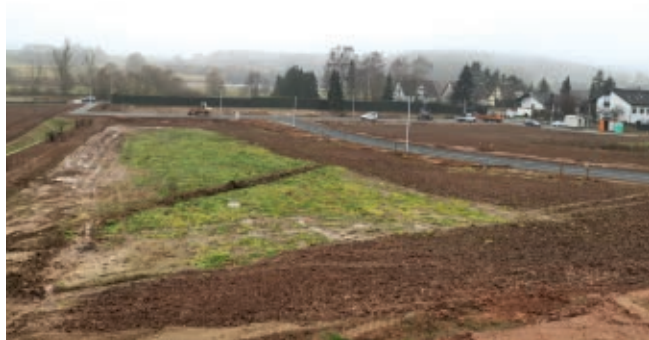
Für das Neubaugebiet „Am Steinig II“ ist die Abnahme durch die Gemeinde Stegaurach erfolgt.
